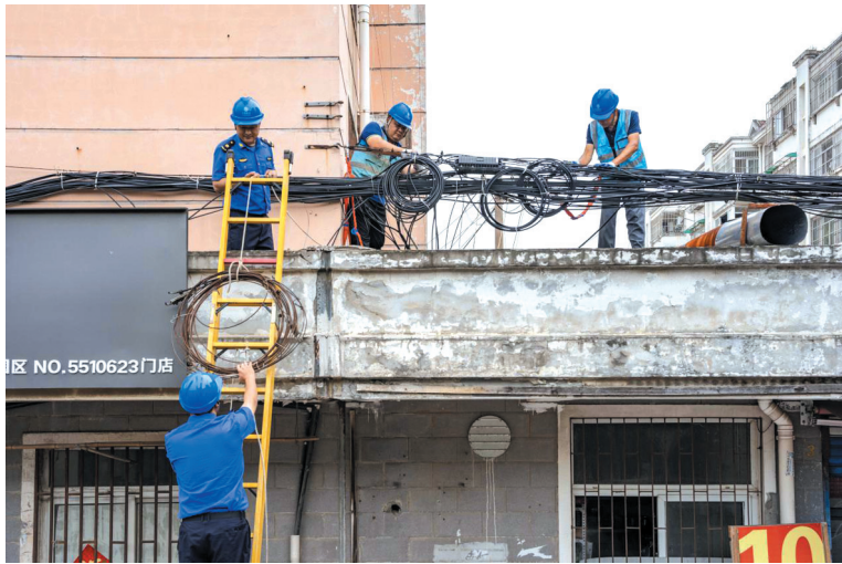
合肥市庐阳区杏林街道金池路望城花园小区居民楼墙体,线缆杂乱无序,9月15日,党员志愿者身着红马甲、佩戴安全帽,开展飞线专项整治作业,对废弃光缆剪除清运、规整处置。
