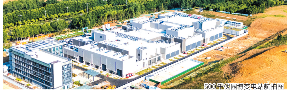
500千伏园博变电站航拍图
