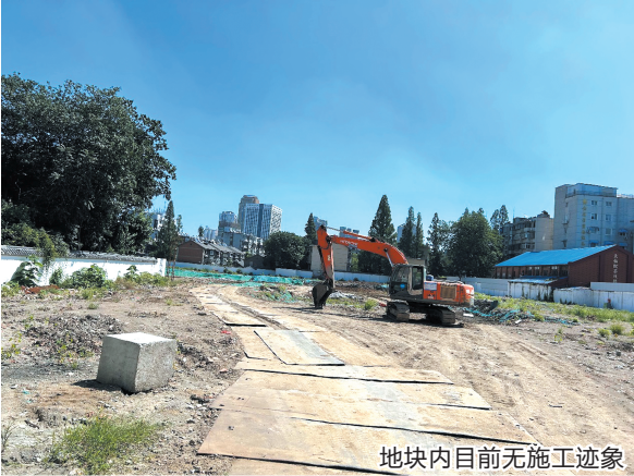
地块内目前无施工迹象
