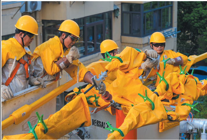
合肥供电连夜升级配网线路
