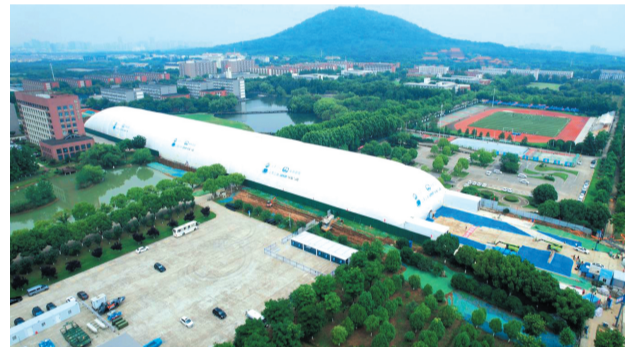
合肥市重点局在南二环西延工程2标段施工现场首次运用气膜结构，该气膜结构采用无柱梁模块化设计，布设长度达330米，为安徽省最大单体基坑气膜，也是省内首个应用于市政场景，其兼具防尘性、降噪性、智能性的功能，可实现基坑施工区域全封闭覆盖，防尘效率可达90%以上。张晓霜 记者 王珊珊
