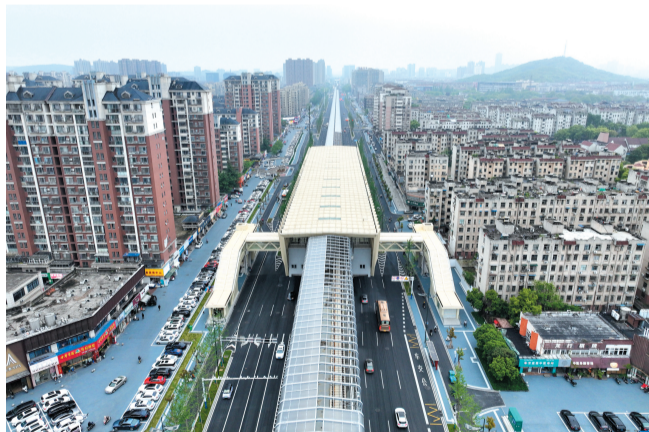
宁马市域(郊)铁路湖北路二总站航拍
