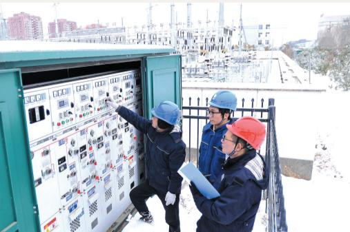
1月20日，在安徽省明光市工业园区，国网明光市供电公司运维人员正在使用红外测温仪、无人机等设备对供电线路及设备进行巡视检查。针对低温雨雪天气可能对供电设备的影响，供电运维人员对易覆冰区域导线覆冰、绝缘子破损、线夹过热等隐患开展全面排查，确保低温天气下电力可靠供应。
