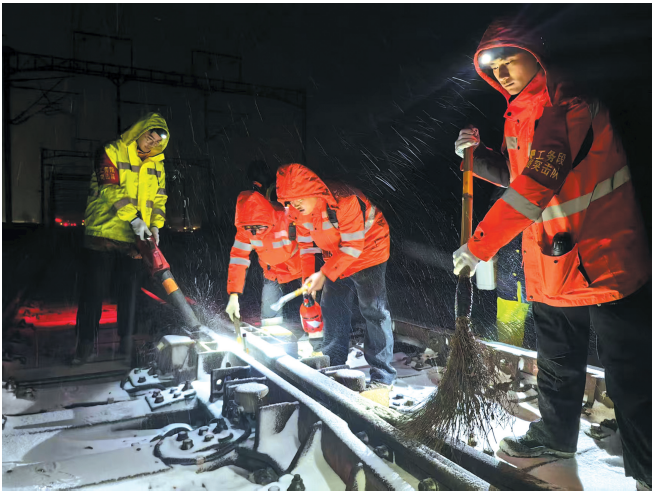
合肥工务段职工利用吹雪机进行扫雪除冰和打冰作业 雷耀 摄
