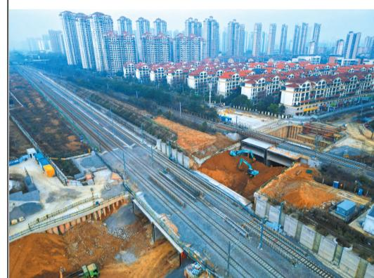
星报讯(记者 王珊珊 通讯员 张晓霜)记者从合肥市重点局获悉,近日,明珠大道下穿合武绕行线、合西联络线工程迎来重要节点——顶进箱涵施工顺利完成。这一节点标志着工程主体结构突破
