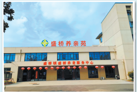
庐江盛桥养亲苑(乡村田园养老)
