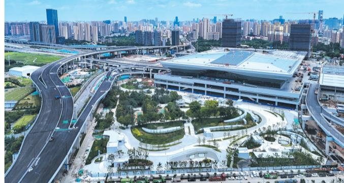
星报讯(记者 王珊珊/文 周诚/图)近日,合肥西站建设传来喜讯,历经8小时连续作业,重达3100吨的东侧站房屋盖钢结构精准提升至41.138米高空,与西侧站房成功对接,这标志着东侧站房正式进入金属屋面施工阶段,站房初步成型,预计今年年底合肥西站将全面建成并具备通车运营条件。
