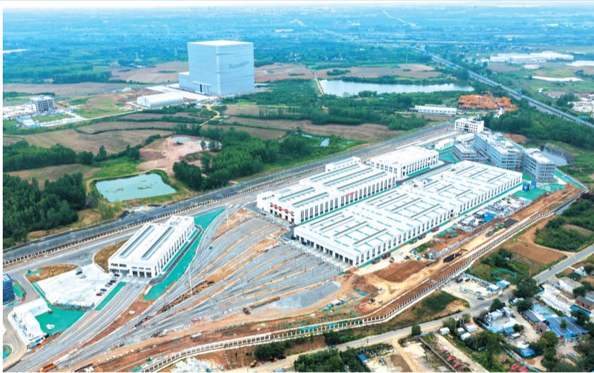
6月16日,在合肥市新桥机场S1线岗集车辆段项目现场,工人们正在施工。作为合肥重点交通工程,合肥新桥机场S1线岗集车辆段项目总建筑面积约7.5万平方米,包含运用库、检修库等17个单体,项目建成后将承担合肥新桥机场S1线列车的停车检修及调试的相关工作。
