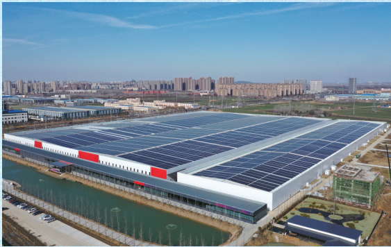
宿州泗县泉为高效异质结光伏电池片及光伏组件项目
