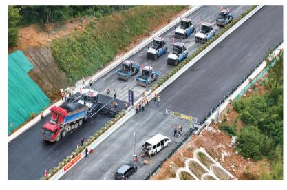
6月1日,在宣泾高速一期01标项目施工现场,安徽建工建设投资集团施工团队采用无人驾驶摊铺机、压路机,进行高速公路沥青面层的无人摊铺及碾压。此次施工是安徽高速公路项目首次实现"无人摊压机群施工",对比传统有人施工,无人摊压技术可将施工效率提高约50%。
