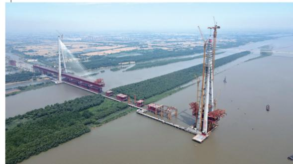
这是5月22日拍摄的巢马城际铁路马鞍山长江公铁大桥4号墩主塔(右)封顶施工现场(无人机照片)。当日,由中铁大桥局承建的巢马城际铁路(巢湖至马鞍山)马鞍山长江公铁大桥4号墩主塔顺利封顶,该主塔为大桥中塔柱,塔高345米,是全桥最高主塔。至此,巢马城际铁路马鞍山长江公铁大桥三座主塔全部实现封顶,即将全面进入钢梁悬臂架设阶段。
