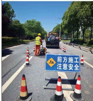
近期,合肥高新区城管大队接到群众反映,园区部分道路出现坑洞,影响通行安全。高新区城管大队组织养护人员8名,并调派切割机、小型压路机等机械车辆共4台,采用机械与人工相结合的方式对习友路、长江西路、方兴大道路面坑洞进行集中处理。目前,相关路面已恢复了平整畅通。
