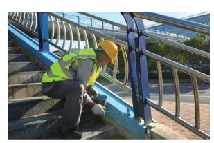
近期,合肥高新区城管大队抢抓晴好天气,对园区重点 道路桥梁开展"除锈刷漆"作业。刷漆后的桥梁护栏整洁美 观,有效改善桥梁运行的舒适度和安全性,为园区通行安全 记者 马冰璐 通讯员 胡慧娴
