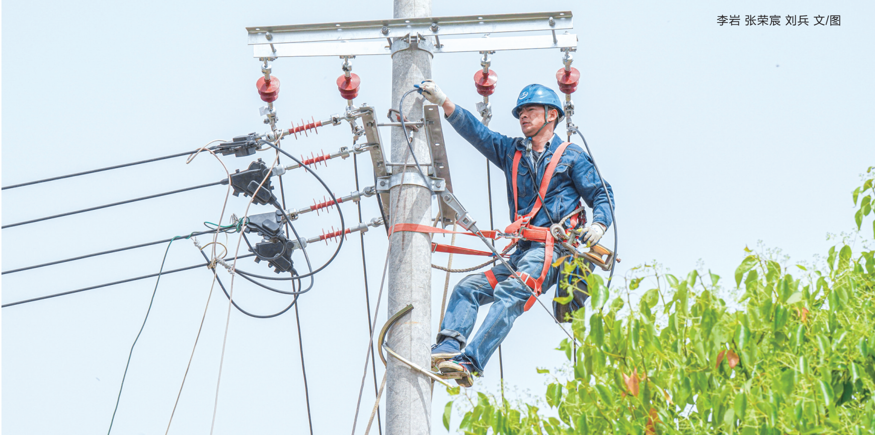
合肥巢湖市供电公司工作人员在中庙街道开展低压线路改造
