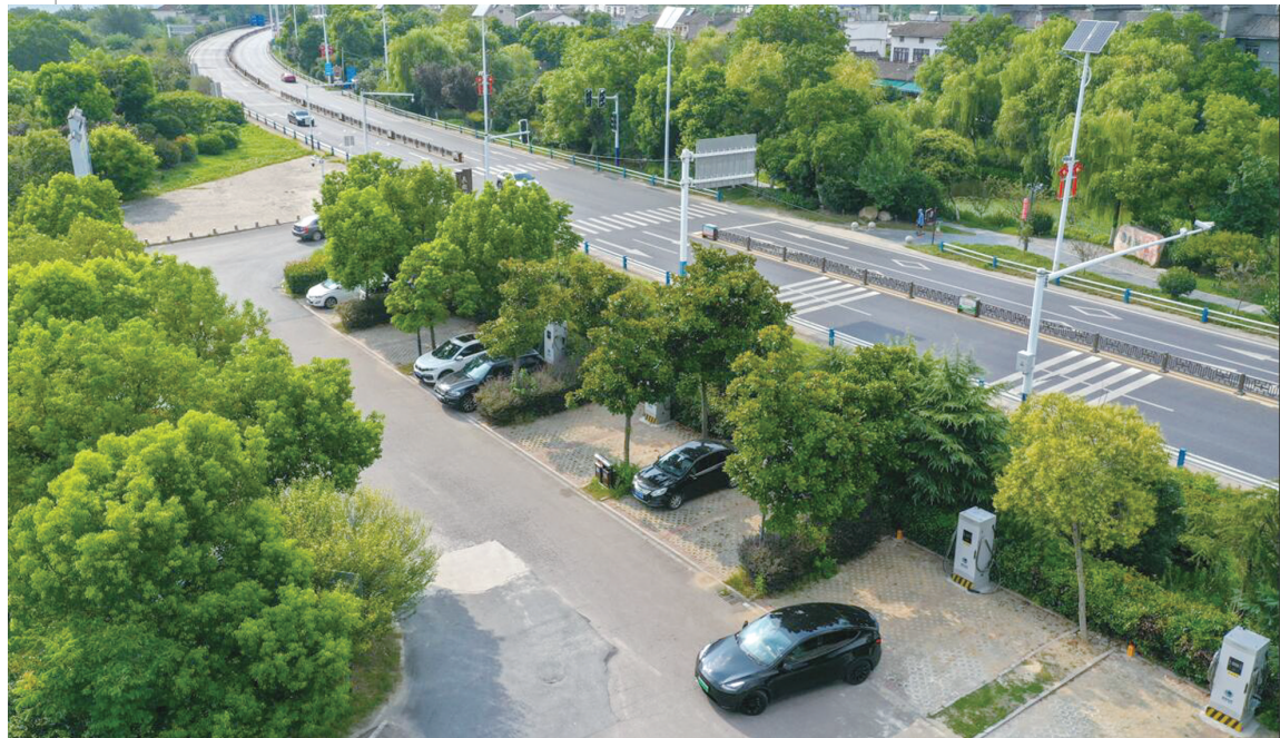
8月7日,在合肥市肥县长临河古镇的国家电网快速充电站,前来游玩的市民正在停车间隙给爱车充电
