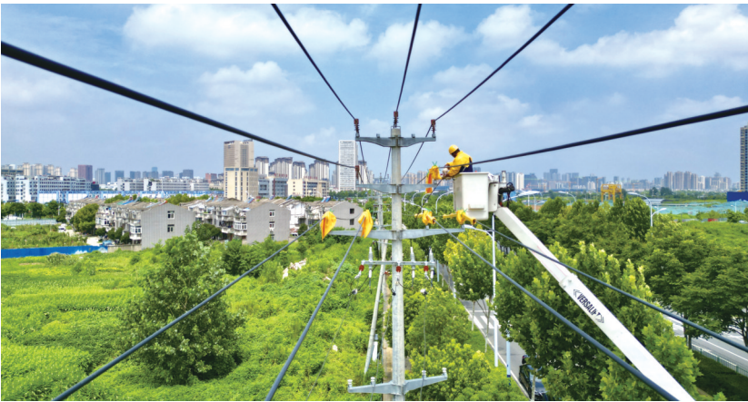
合肥电网对线路进行检修
