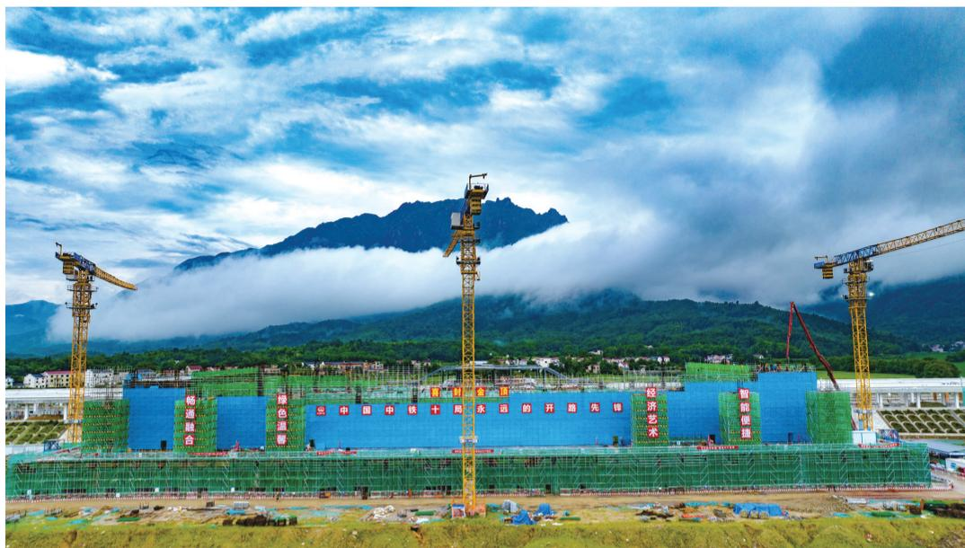
九华山站站房混凝土主体结构浇筑施工现场。李良图/摄
