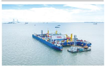
"一航津安1"号沉管运输安装一体船在沉放安装E23管节和最终接头,背后是建设中的深中通道伶仃洋大桥(6月9日摄,无人机照片)。 新华社发
