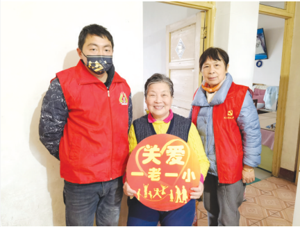
为弘扬社工精神,在社工日来临之际,合肥市新站高新区七里塘社区联合安泰社工开展关爱特殊老年志愿服务,组织辖区志愿者为2位特殊老人安装卫生间扶手,保障老人居家安全。通过此类服务,满足了辖区特殊老人的生活需求,同时提高了居民对社工的了解,让服务对象能够在有需求时找社工。
