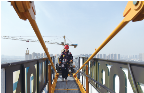
徐引娣上岗前检查塔吊的钢缆情况
