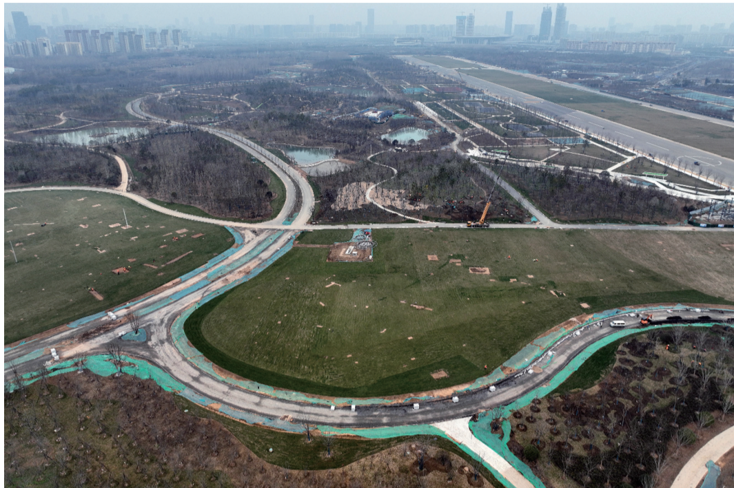
建设中的骆岗中央公园
