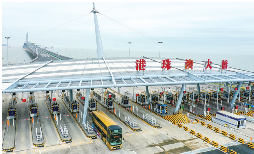
1月8日,一辆从香港开往珠海的港珠澳大桥穿梭巴士入境珠海(无人机照片)。新华社记者 刘大伟/摄
