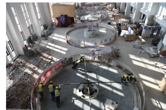
正在施工的泵站
