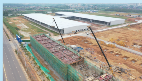
韵达产业园建设现场航拍
