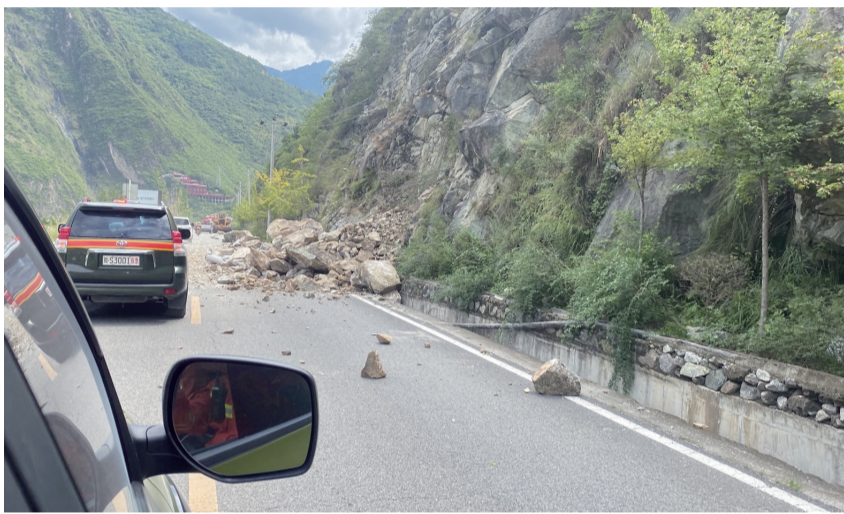
这是9月5日四川省森林消防总队甘孜支队在前往泸定县的路上发现的塌方情况。 新华社发
