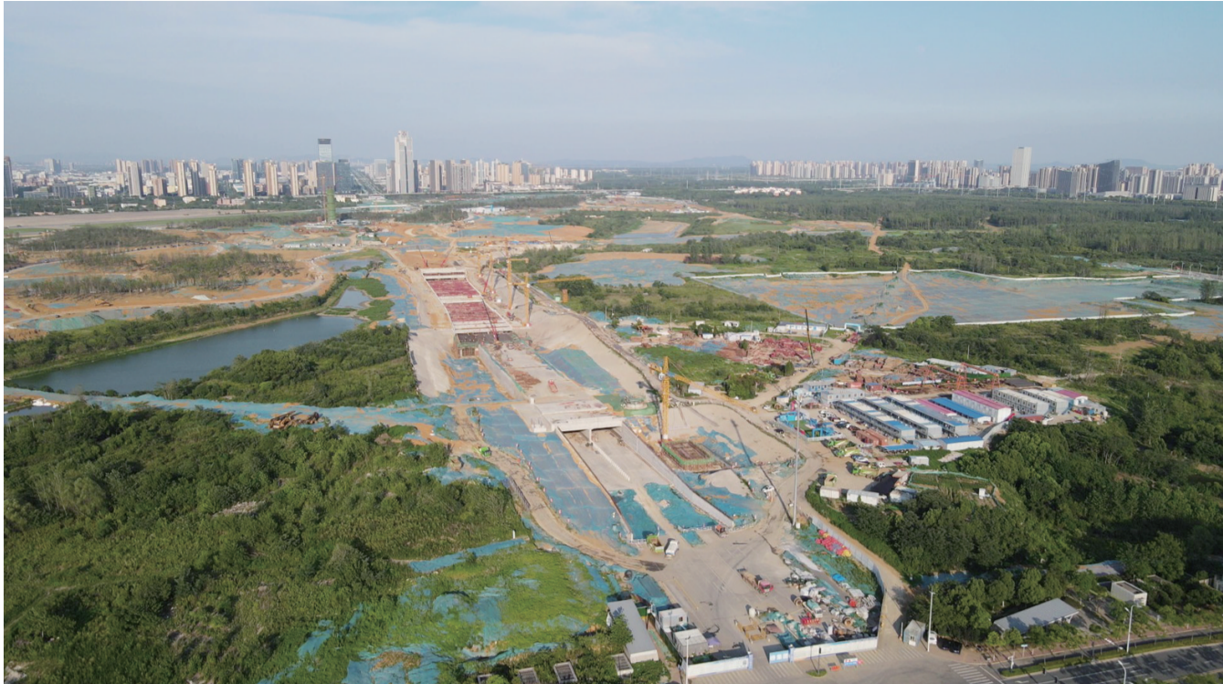
合肥骆岗公园重点市政道路建设项目——花园大道项目加紧施工中
