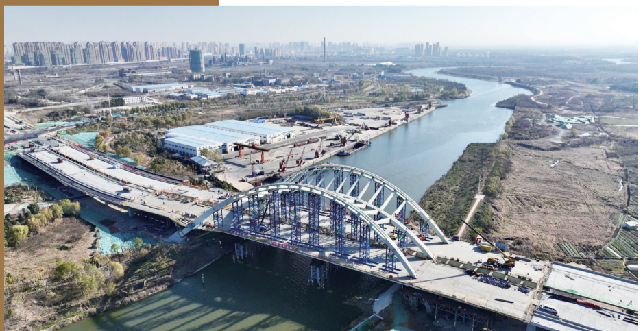
广德路跨南淝河大桥
