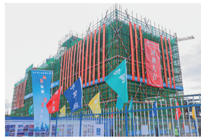
施工中的安庆福田雷萨项目
