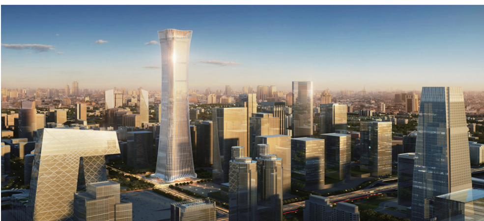
中建安装的重点获奖工程——中国尊
