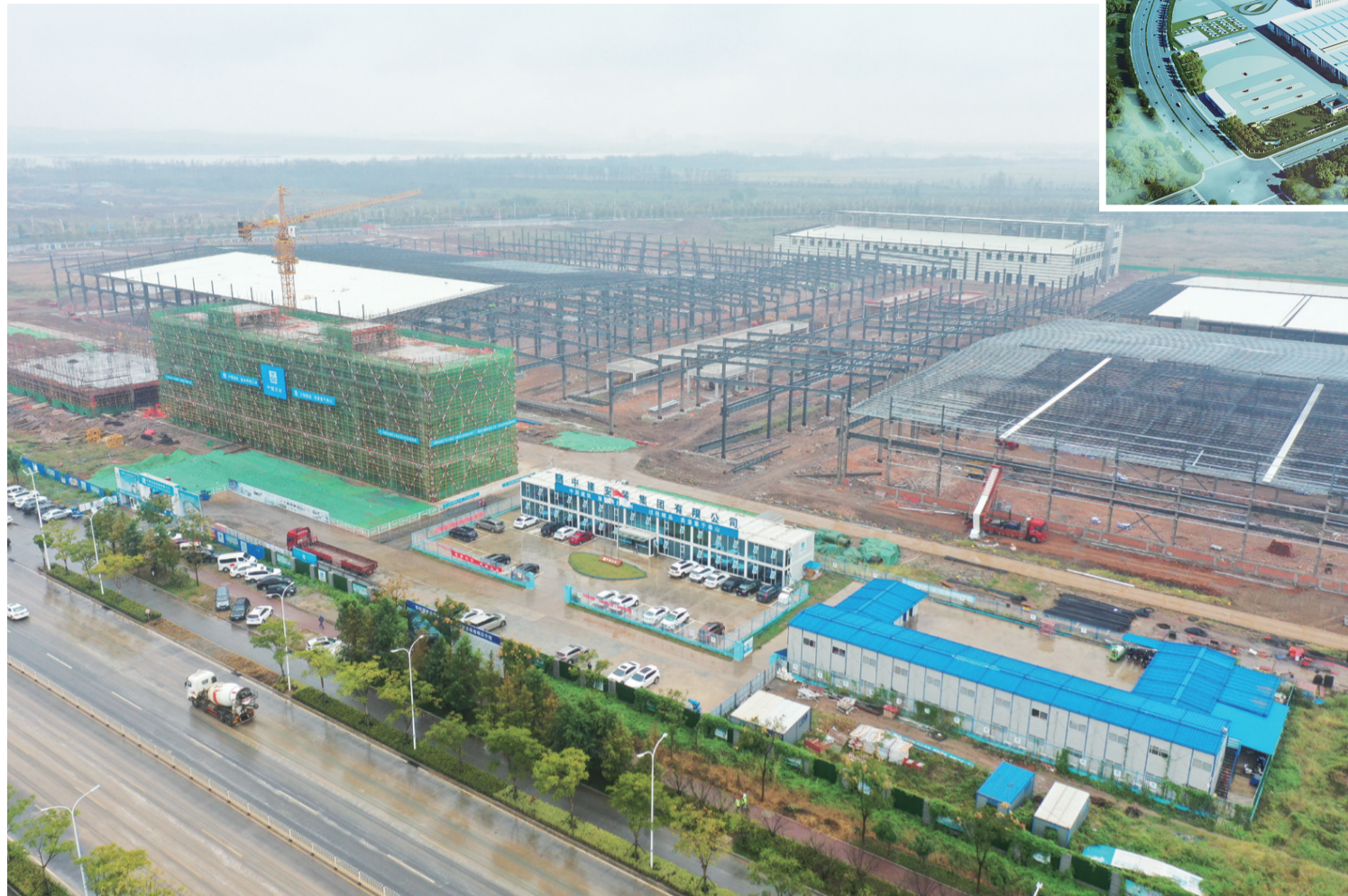
俯瞰安庆福田雷萨项目
