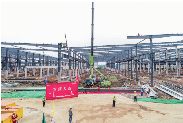
一号厂房最后一根钢梁缓缓升起
