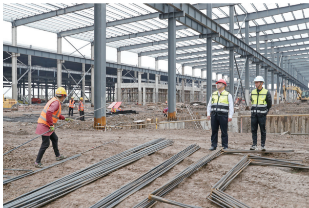
工作人员在项目现场实地查看
