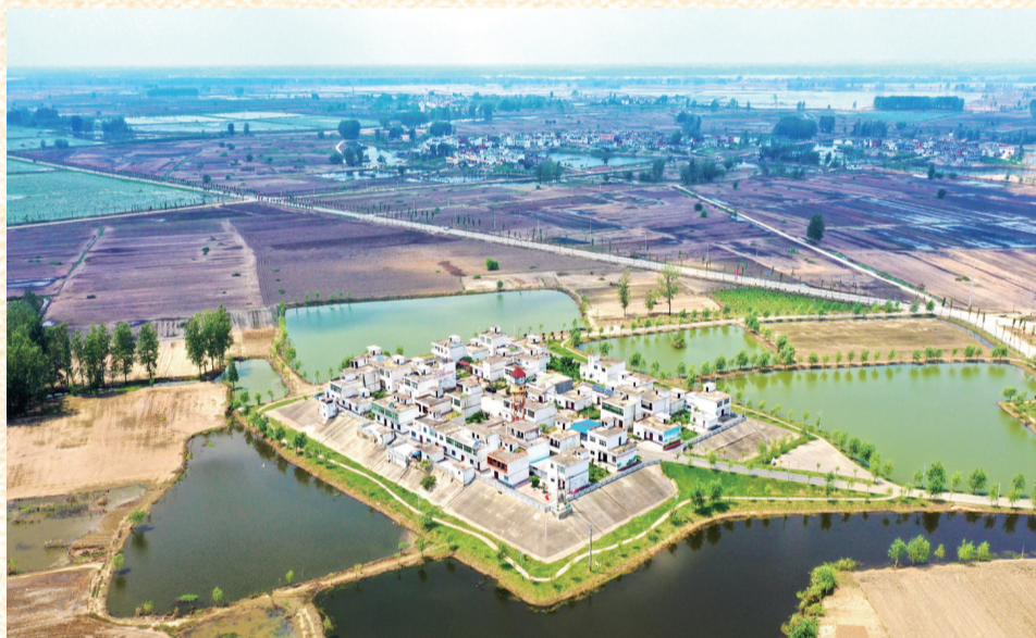
改造后的阜南县蒙洼蓄洪区曹集镇利民村西田坡庄台
