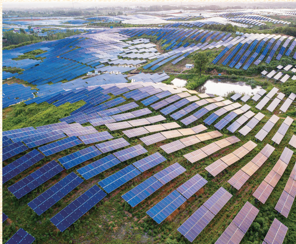
金寨县累计投入 14.78 亿元,建成并网光伏扶贫电站 20.11 万千瓦。图为金寨县白塔畈镇 10 万千瓦集中式光伏扶贫电站。
