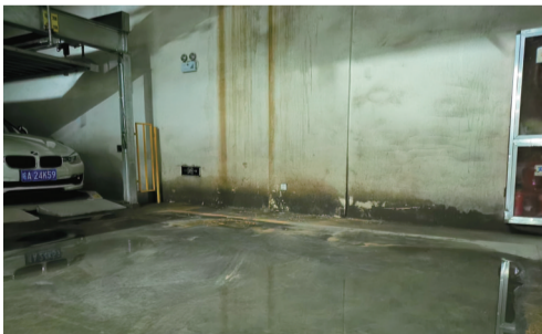
地下车库一角
