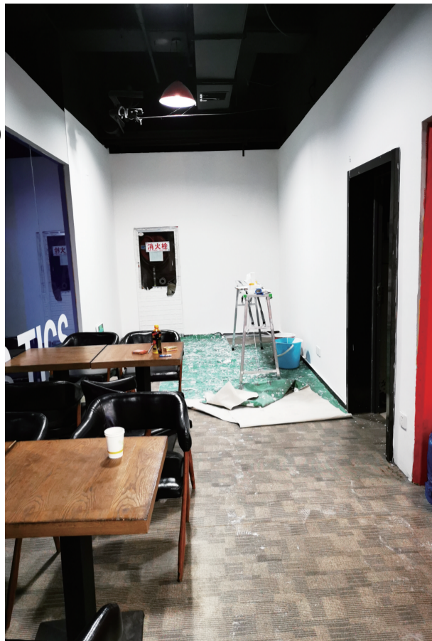
转让后的健身馆正在装修
