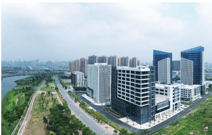
瑶海区正在打造“一谷三基地”产业承载平台
