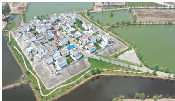
航拍西田坡庄台
