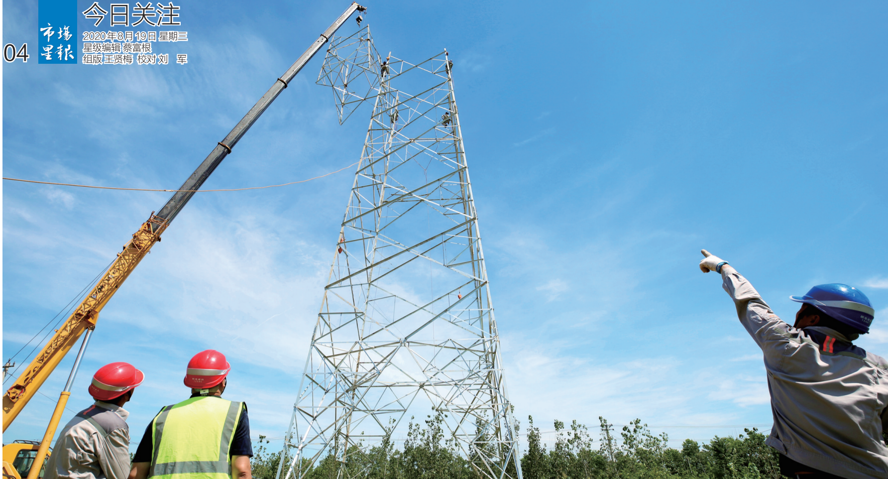
电力工人头顶烈日正在加紧施工
