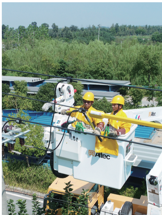
工作人员正在进行带电接火作业
