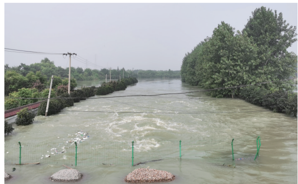
正在排水的泵站,洪水漫溢
