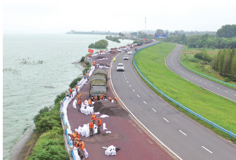
环巢湖大道肥西严店段防浪堤加固现场
