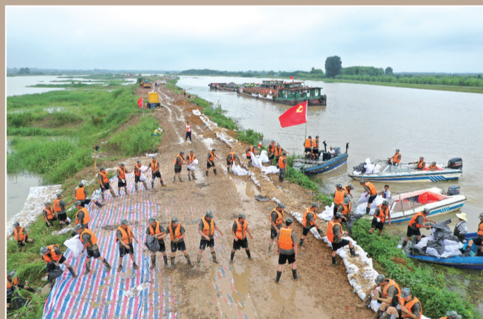
抢险现场动用大船和冲锋舟运送石子
