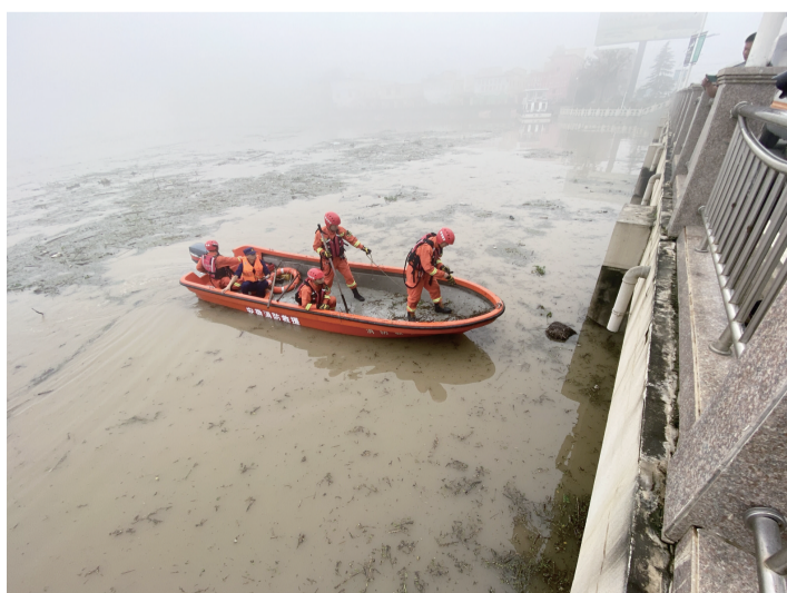
早上7点钟，消防队员乘船检查王家坝闸门口。
