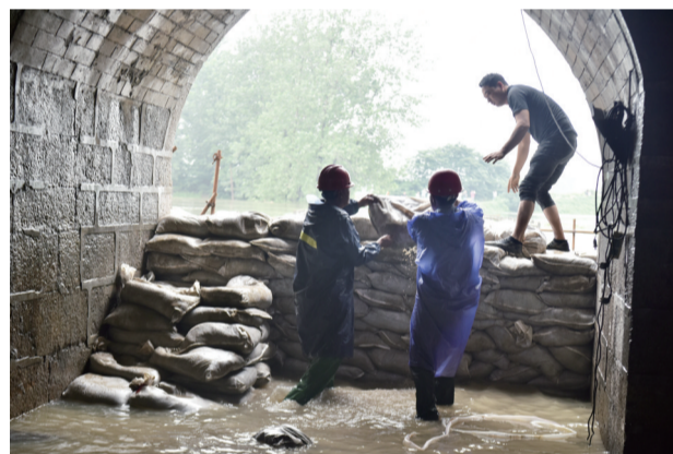
宾阳门外就是一片汪洋,防汛人员正在不断加高封堵圩堤
