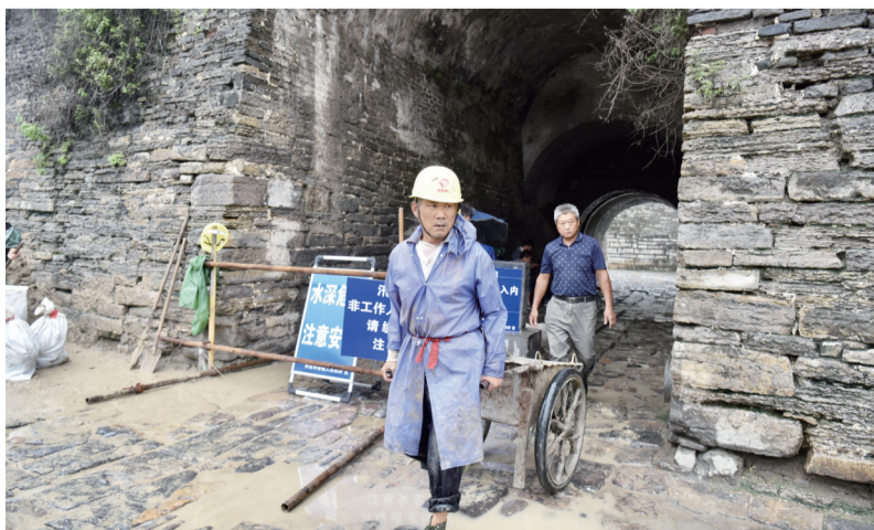
抗洪抢险人员正在搬运沙袋
