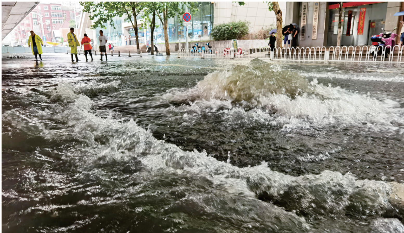
7月19日,在合肥市马鞍山路上,窨井喷出污水,附近路口已经封闭车辆通行。 □ 记者 马启兵
