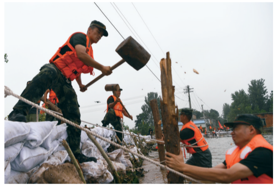
战士们正在打桩构筑子堤
