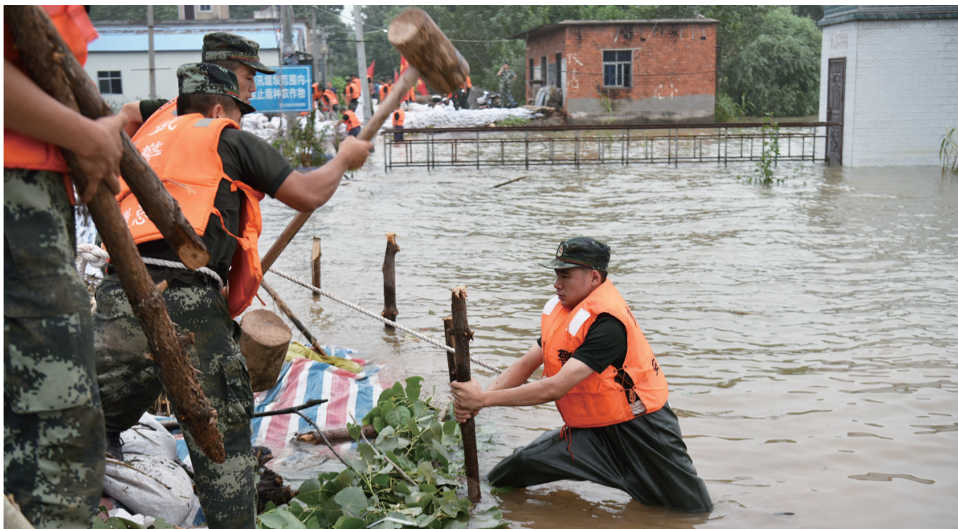
武警战士正在进行打桩作业
