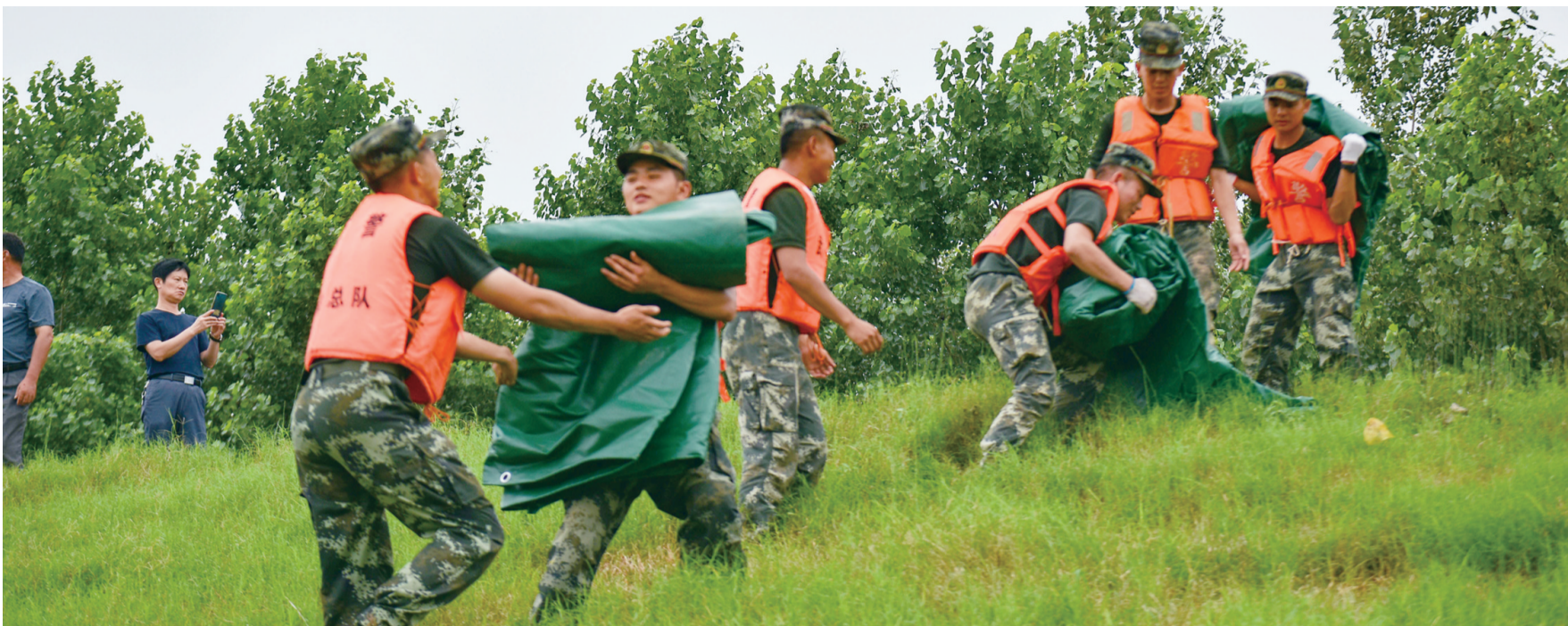
武警战士正在铺防雨布,保护同马大堤雷池段
