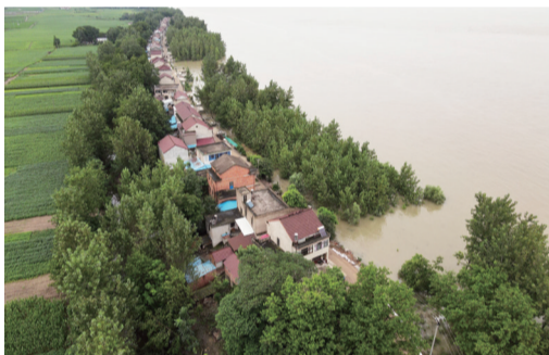
巩固圩水位超警戒线
