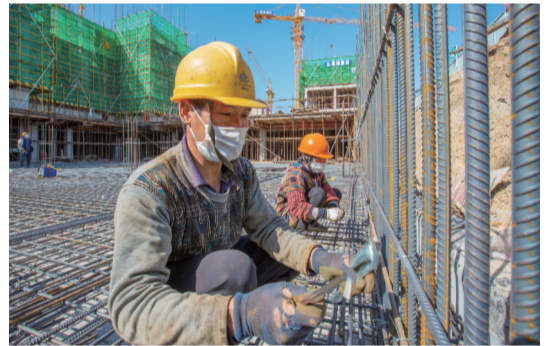
安置工程建设如火如荼
