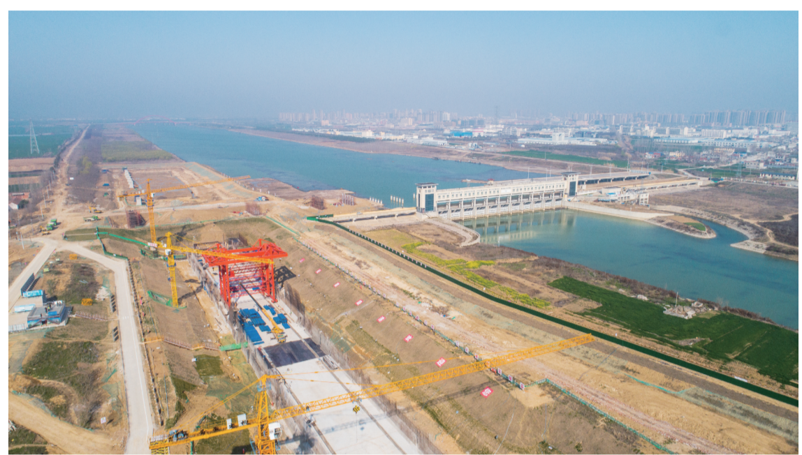
灵璧闸工程有序建设中
