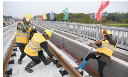
3月26日,中铁四局八分公司工人在进行铺轨作业。
